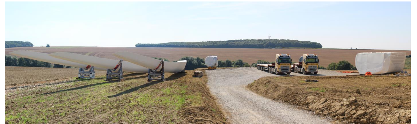
Eléments d'éoliennes avant montage (Source : Ora environnement)
