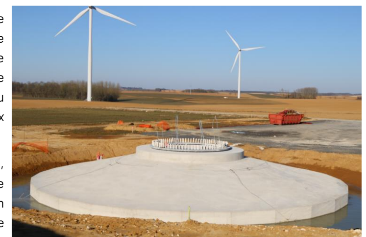
Fondation avant recouvrement
