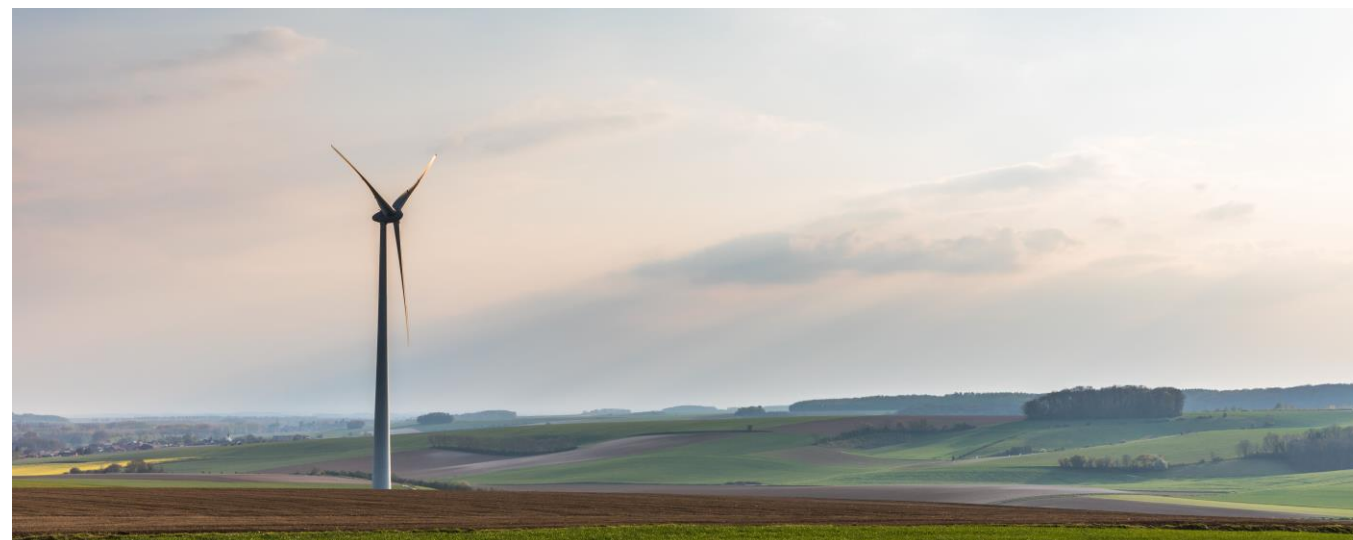
Figure 4 : Parc éolien de la Boule Bleue dans le département de la Somme, projet porté par wpd (Source : wpd onshore France)
